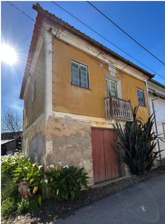
Figura 2: Imóvel na rua da Portela
